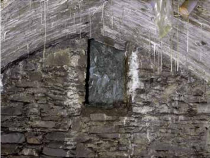
Abb. 10: Blick in die Südost-Rösche des Feuergezäher Gewölbes unterhalb der Firste. Gut erkennbar ist die rasch abfallende Firste dahinter. (© Foto: G. Drechsler/NLD)
