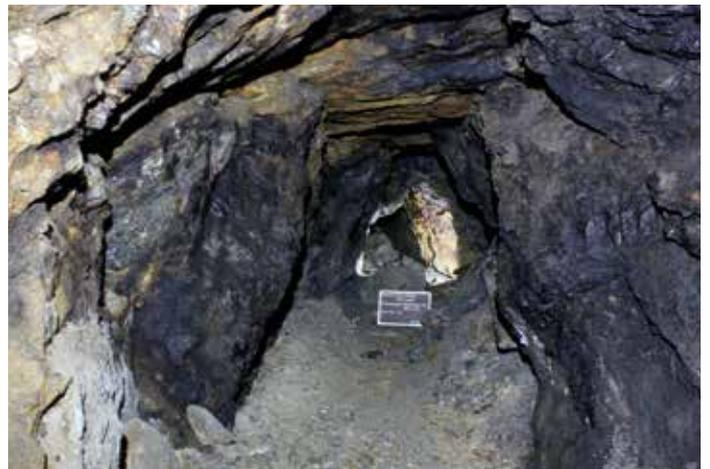
Abb. 12: Kastenförmiger Querschnitt der Nordwest-Rösche, der im unteren Bereich nachgerissen wurde. (© Foto: G. Drechsler/NLD)
