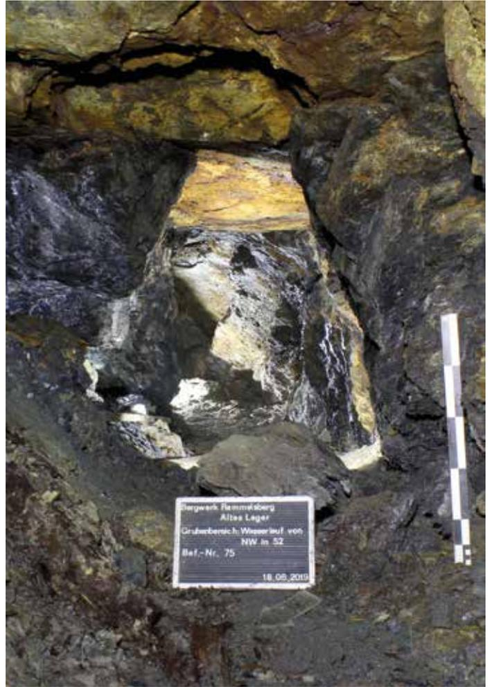
Abb. 11: Blick in die Nordwest-Rösche. Im Vordergrund zeichnet sich das trapezförmige Profil ab, im Hintergrund der unregelmäßige geweitete Bereich. (© Foto: G. Drechsler/NLD)
