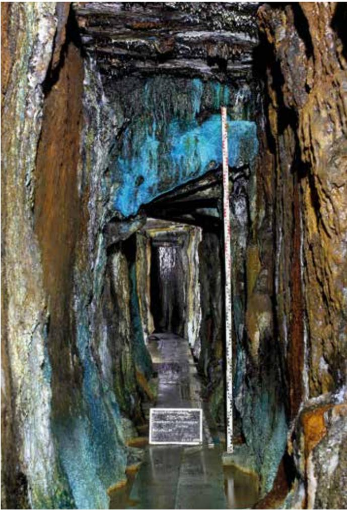
Abb. 4: Rathstiefster Stollen mit Übersinterung der nachgerissenen Stöße. (© Foto G. Drechsler/NLD)
