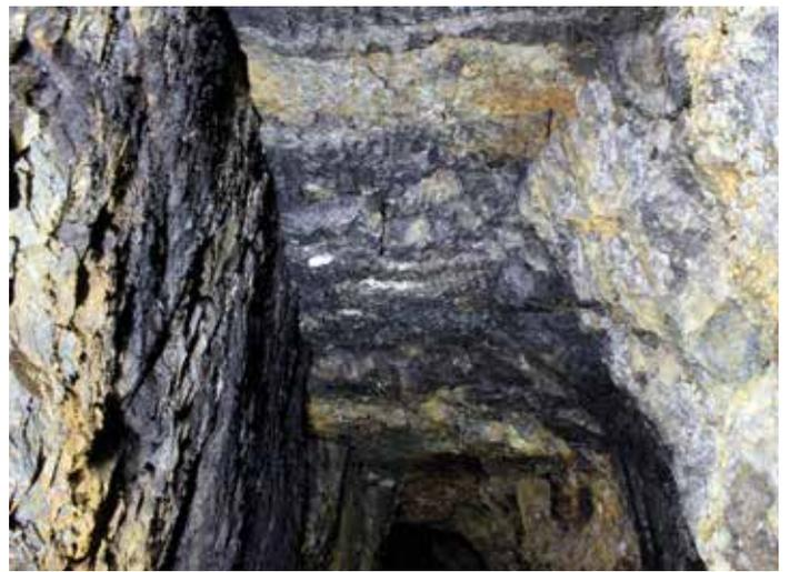
Abb. 18: Schrämmpuren an der Firste des Unteren Wasserlaufs. (© Foto: G. Drechsler)
