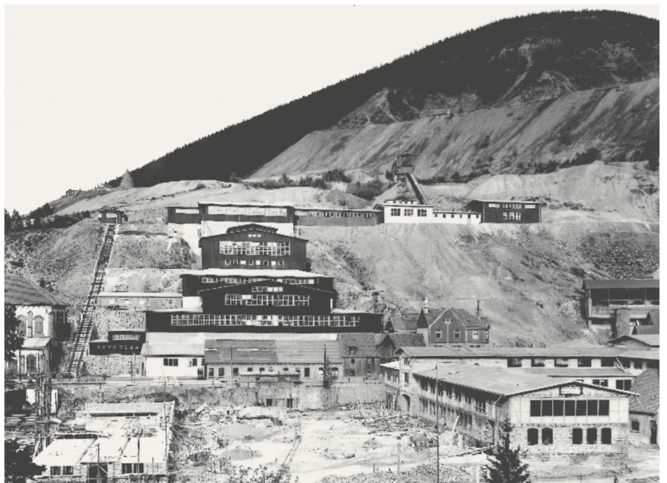
Abb. 1: Die im Bau befindlichen Tagesanlagen des Erzbergwerkes Rammelsberg 1937. (© Foto: Sammlung Weltkulturerbe Rammelsberg)
