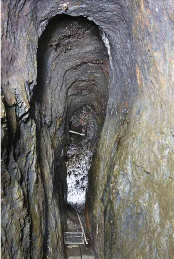
Abb. 13: Querschlag vom Rathstiefsten Stollen zum Alten Abbau. Der Obere Bereich unterscheidet sich deutlich vom unteren. Blick nach Südwesten. (© Foto: Georg Drechsler)
